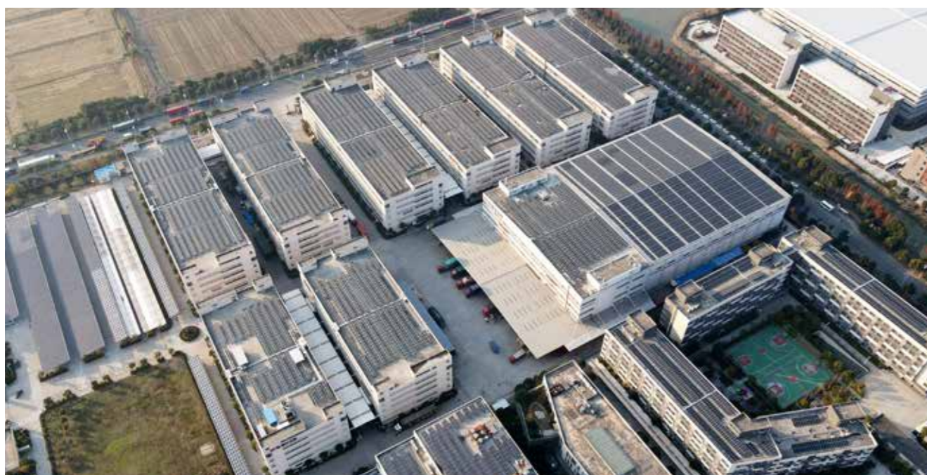
晨光文具光伏屋顶项目 上海
